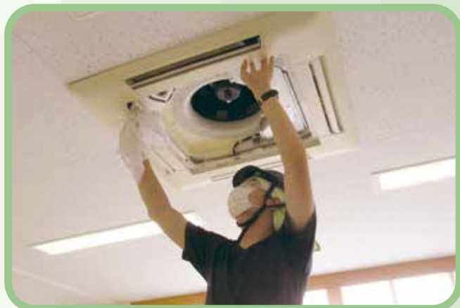
サービスビジネス科ビルメンテナンスコース授業風景 (エアコン清掃) (琴の浦高等特別支援学校) The Service Business Track Building Maintenance Course (A/C Cleaning) (Kotonoura High School for Special Education)
