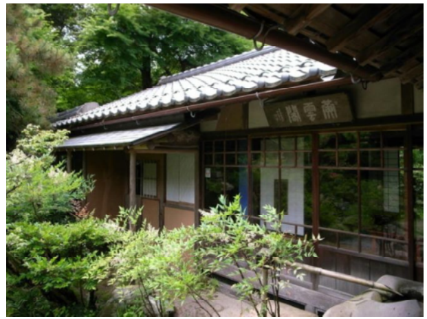
矢田貝家住宅離れ 外観
