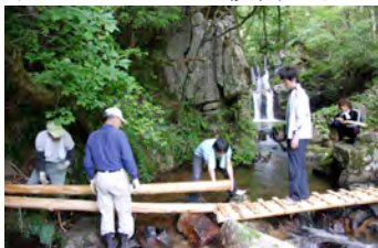
写真3 集落づくり活動への参加 (橋の設置)
