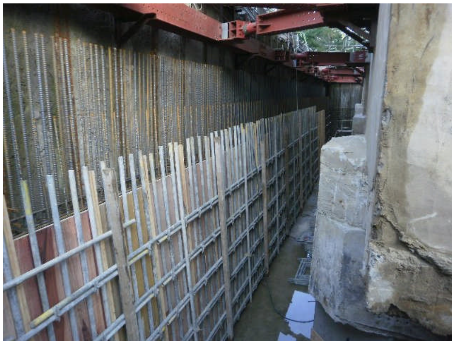
⑥ 本庁舎西面擁壁躯体構築
