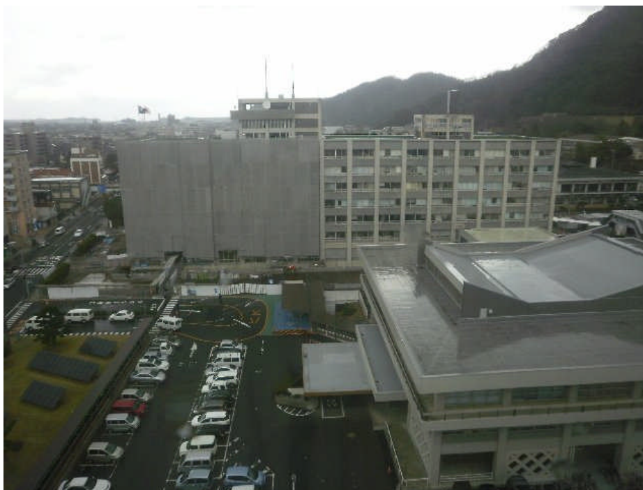
本庁舎（南面より）
