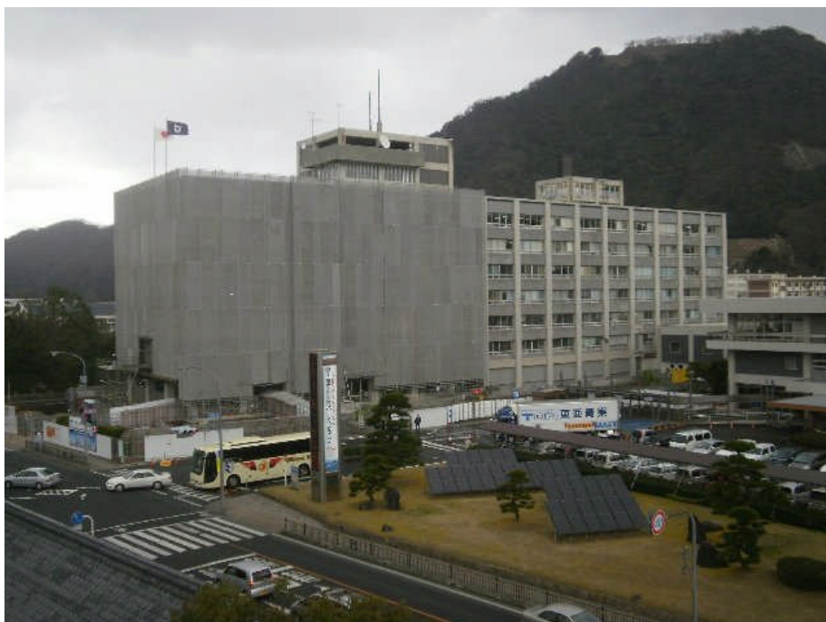
本庁舎（南面より）
