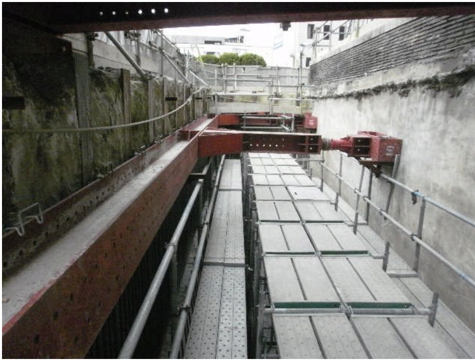
⑤ 本庁舎南面支保工組立
