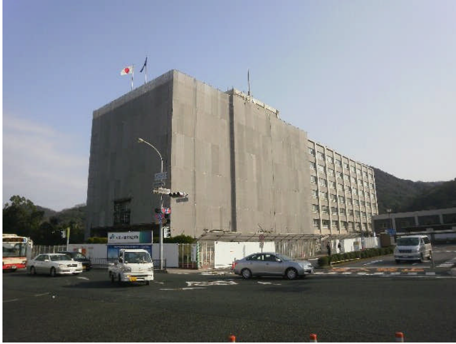
⑦ 本庁舎外部足場組立
