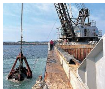
基礎捨石の投入(第1防波堤)
