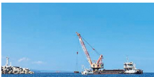
既設被覆ブロックの撤去(第1防波堤)
