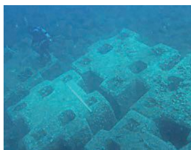
既設被覆ブロックの水中玉掛け (第1防波堤)
