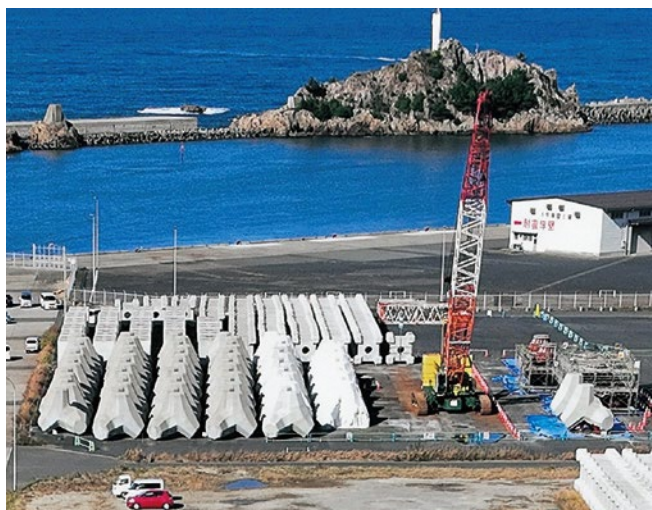
第1防波堤延伸 消波ブロック製作状況(国土交通省事業)
