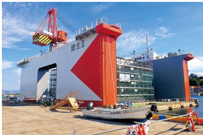
第1防波堤延伸 ケーソン製作状況(国土交通省事業)
