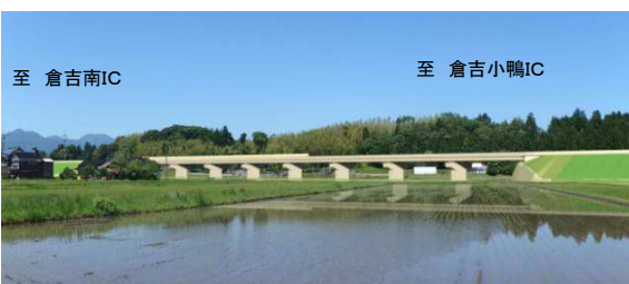
石塚高架橋付近
