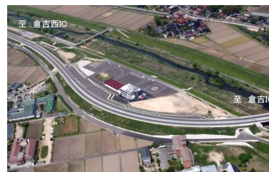
天神川河川防災ステーション付近
