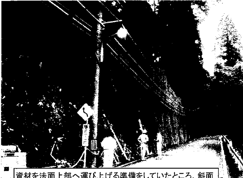
資材を法面上部へ運び上げる準備をしていたところ、斜面上部で待機していた作業員が転落した。
