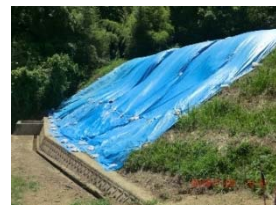
ブルーシートによる被災箇所保護
