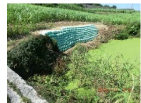
土のうによる崩落箇所の拡大防止
