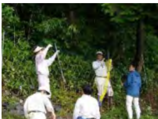
束ねたネットを、塩ビ管に固定しながら広げる。
