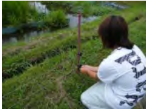
電線の高さや間隔、張りを調整する。
