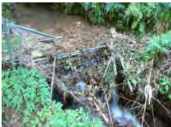
増水により破損した金網柵 河川・水路は、獣類の通り道・エサ場になる。 柵で封鎖するのは困難である。
