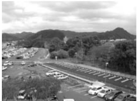
駐車場拡張工事
