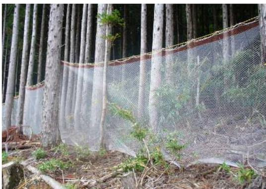
※ 2.5m、3m 幅のネットを使用して、2m 以上の高さを確保して設置。耐久性の向上とシカ誘引を防ぐため、流水処理による塩抜きが必要。
