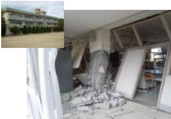
柱が破壊し、床の沈下が起こった例
