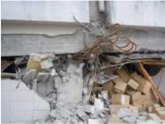
1階が層崩壊した例
