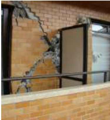
非構造壁の被害
