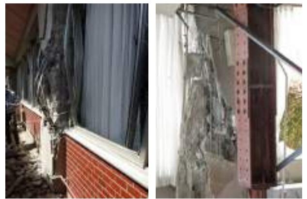
構造部材が損傷を受けた例
