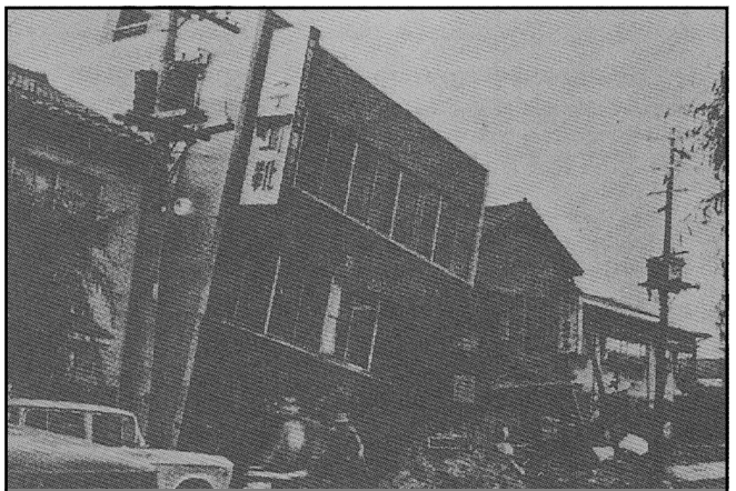
全体沈下が1mを超える被害例
