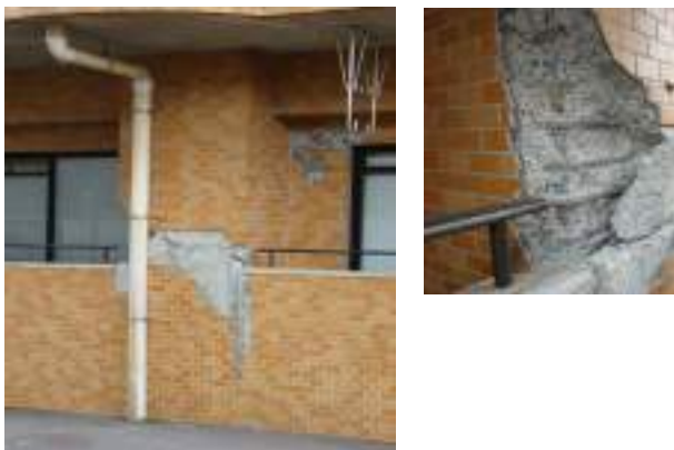
構造部材が損傷を受けた例
