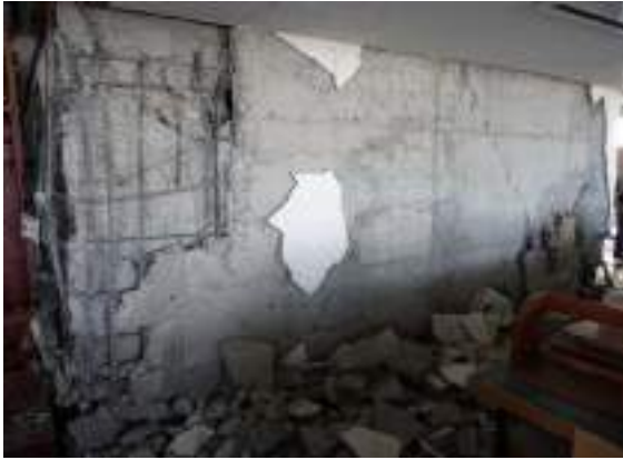
構造部材が損傷を受けた例
