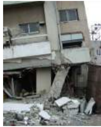
1階が層崩壊した例
