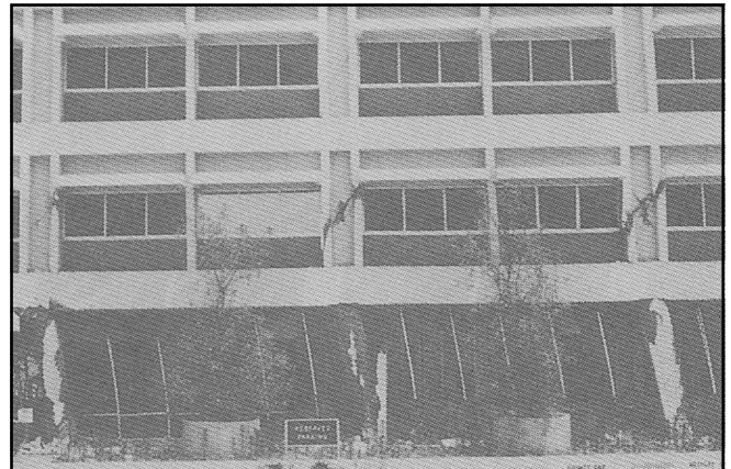
柱の損傷に伴う大きな水平変形の被害例
