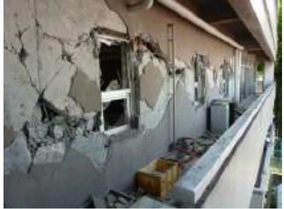
非構造壁の被害
