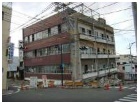
1階が層崩壊した例
