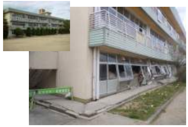
柱が破壊し、床の沈下が起こった例
