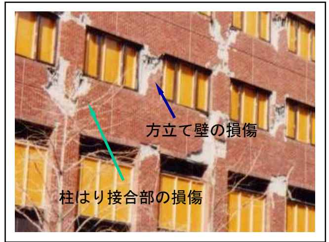
柱はり接合部の損傷 方立て壁の損傷
