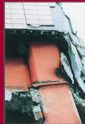
写真-19 柱と通しダイヤフラムとの溶接部の破断
