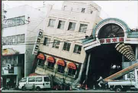
写真-7 アーケードへの倒壊の危険性のある建築物
