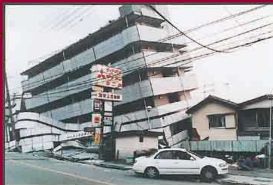
写真-3 低層階で落階した建築物
