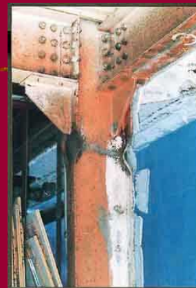
写真-13 局部座屈を生じた柱
