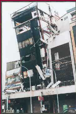
写真-11 傾斜した建築物
