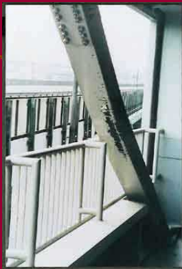
写真-17 H形鋼筋違の座屈
