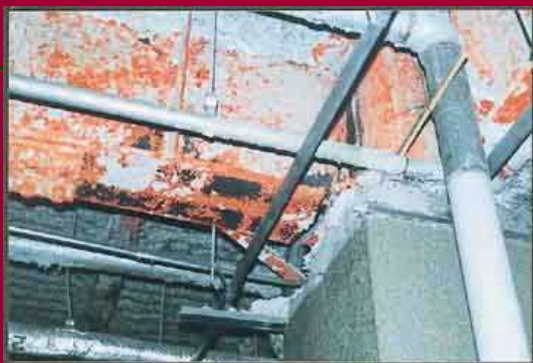
写真-2 同上建築物内部の梁端部の降伏及び破断
