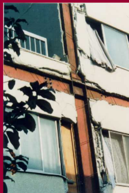
写真-23 落下危険物Cランクの例
