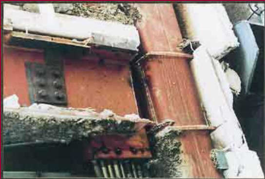
写真-18 梁端部溶接部の破断
