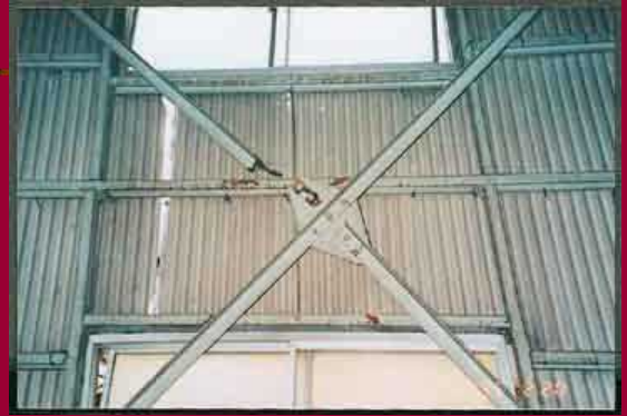
写真-16 アングル筋違の破断
