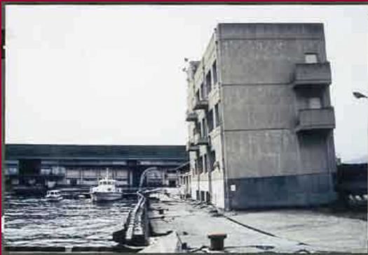
写真-9 地盤の測方流動(護岸の移動)のため傾斜した建築物
