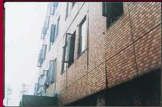
写真-1 純ラーメン5階事務所ビルのPCカーテンウォールの損傷
