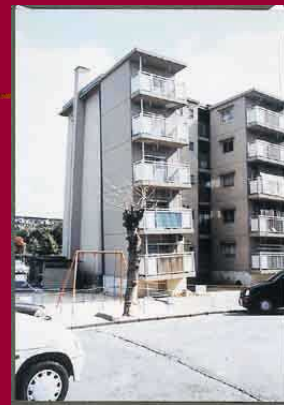
写真-10 不同沈下のため傾斜した集合住宅
