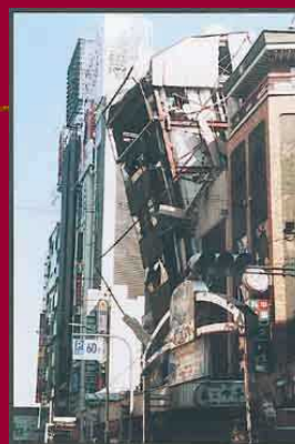
写真-4 著しく傾斜した建築物
