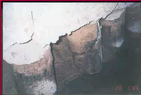
写真-5 杭の著しい破損
