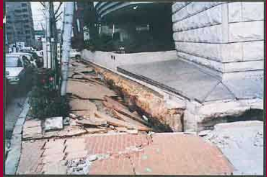
写真-8 地盤の液状化のため沈下した建築物周辺
