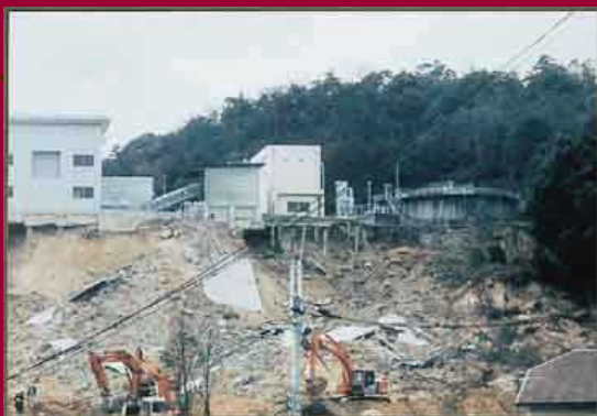
写真-6 建築物の敷地の崩壊危険
