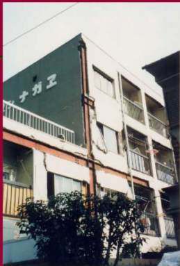
写真-23 落下危険物Cランクの例
