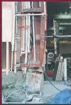
写真-15 全体座屈を生じた柱
