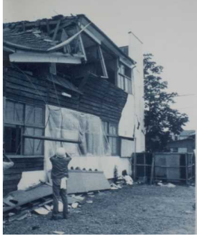
写真-5 建築物の不同沈下
