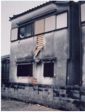
写真-11 壁の被害(外壁)
