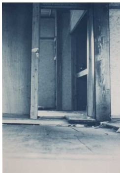
床板を見ても殆ど傾斜が見られない：Aランク
