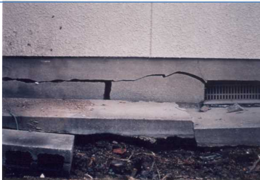
写真-6 基礎の被害
