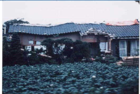
写真-4 建築物の不同沈下
