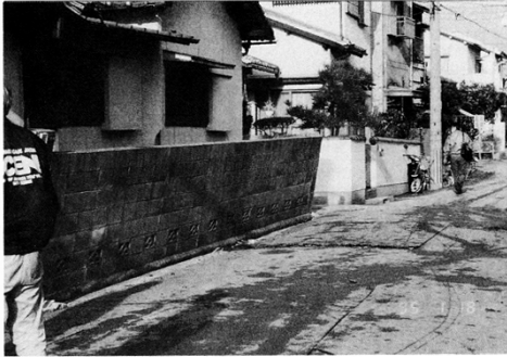
ブロック塀が大きく傾いている。写真ではわかりづらいがぐらぐらしている。要注意：Cランク
