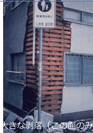
写真-12 壁の被害(外壁)
