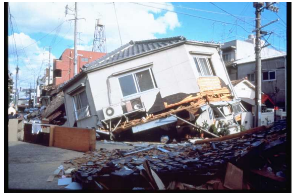
2階建店舗併用住宅。1階崩壊。
