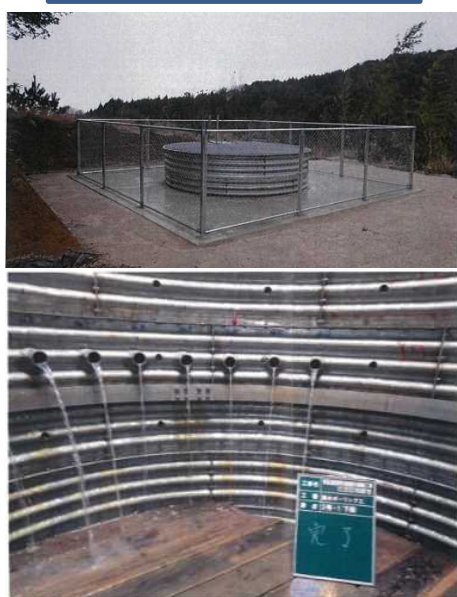
実施後(集水井工 9基)
