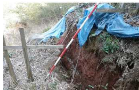
被災状況(ブロック頭部の変状)
