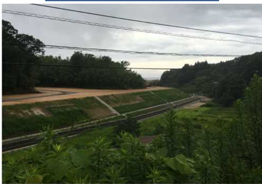
実施後(押え盛土工 55,500m 3 )
