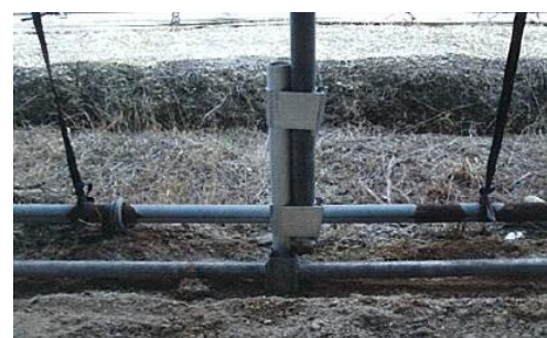
写真5 パイプ地際の腐食部分の補強
