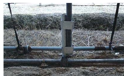
写真5 パイプ地際の腐食部分の補強
