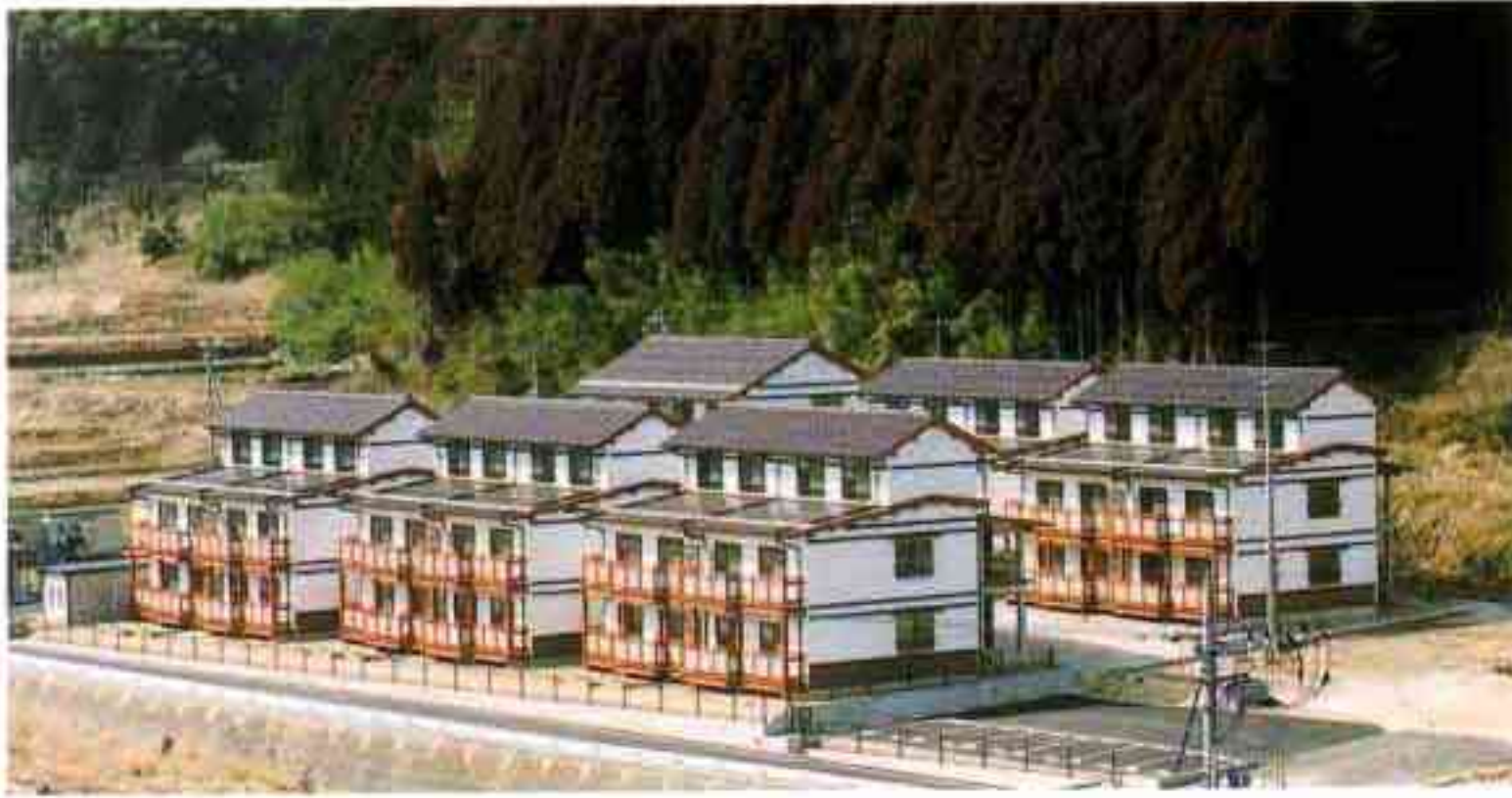
県営住宅杉の香団地(智頭町) 杉材を多用した木造3階建て共同住宅
