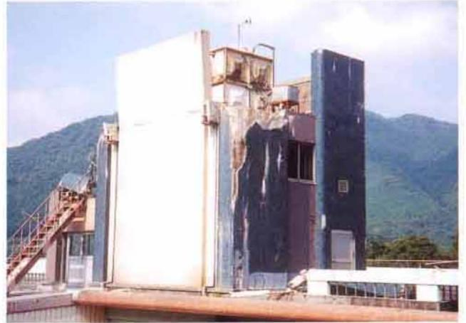
▲病院建物4階の搭屋に設置している受水槽が破損し、診療所にひび割れ、水漏れ発生
