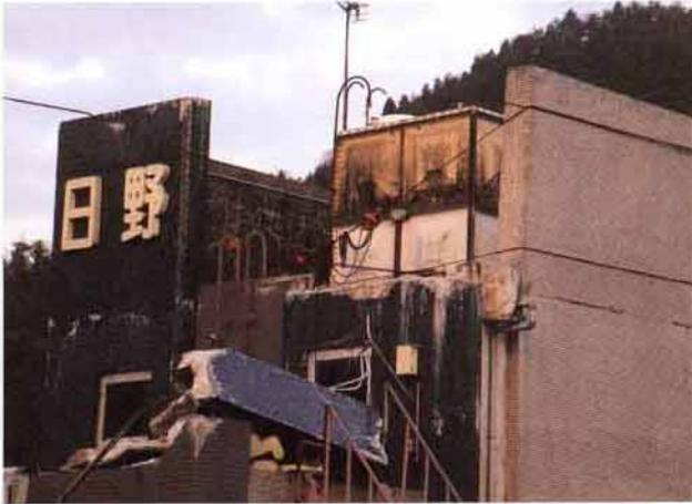
▲屋上に設置しているコンクリート製の看板が根元から割れて3階会議室の上に落下し、屋上がひび割れ多量の雨漏りが発生。残った部分もひび割れ、落下の恐れがあり診療棟は立入禁止（赤札）となった。
