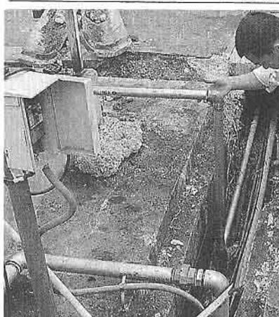
地震で破損した冷蔵庫用の燃料パイプを修復する作業員—境港市昭和町、大伸水産本社工場
