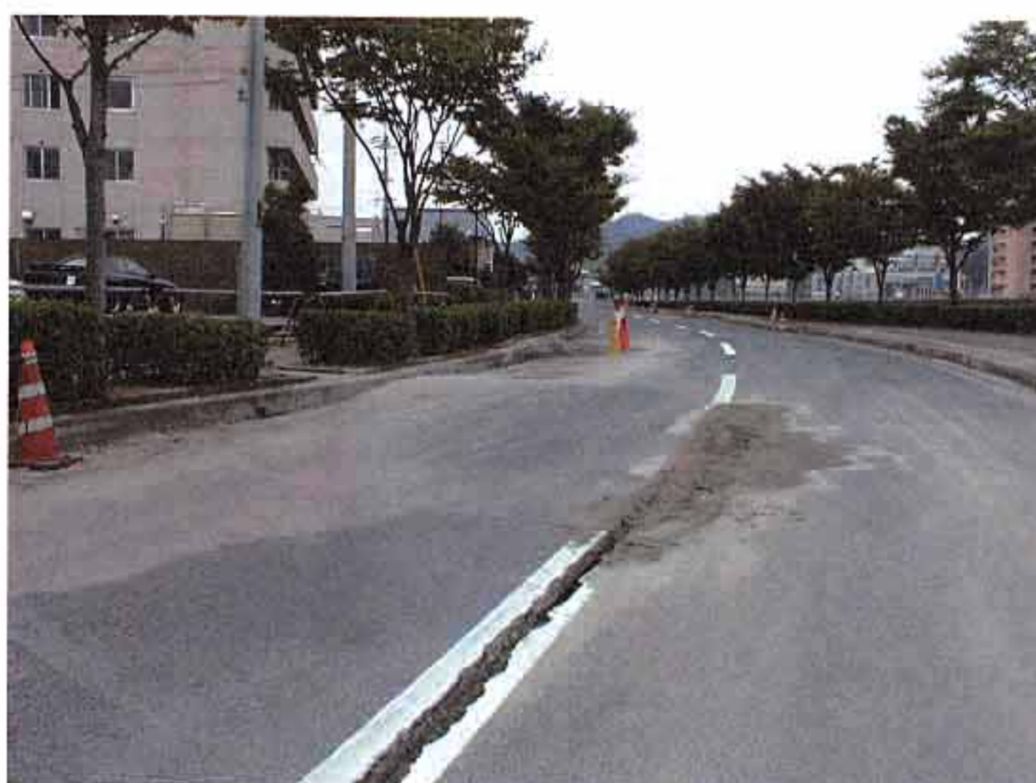
写真 7.1.1：錦海町で見られた噴砂 ・路肩だけでなく、割れた路面中央からも噴砂が生じている。
