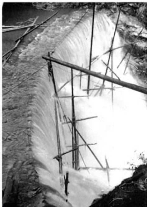
施工中の増水
