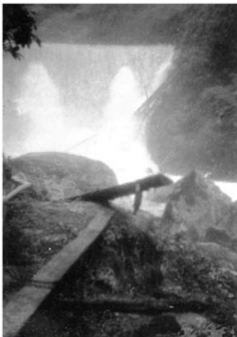
施工中の増水
