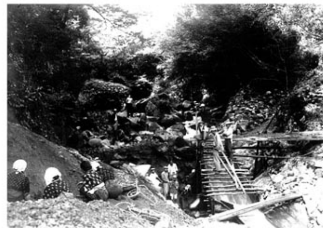
仮排水路、左は現地採取した細骨材
