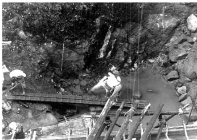
床掘状況、右側に堰堤の根石が見える
