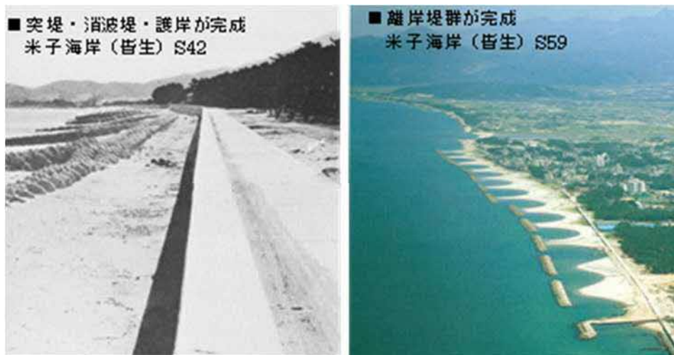
皆生海岸（米子海岸米子西地区）の海岸侵食対策
