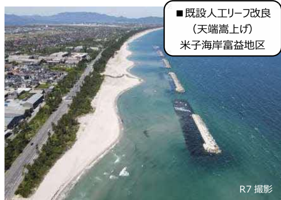
既設人工リーフ改良整備状況
