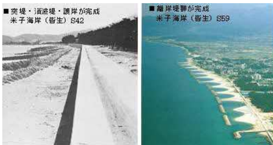
皆生海岸の海岸侵食対策
