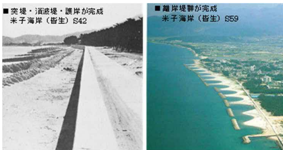
皆生海岸の海岸侵食対策
