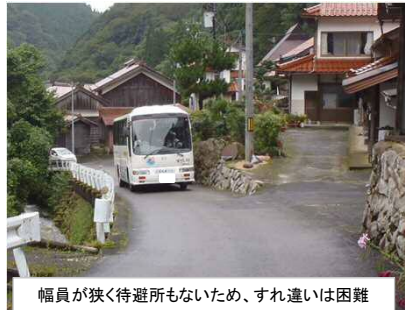
幅員が狭く待避所もないため、すれ違いは困難
