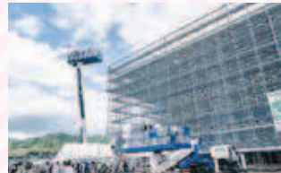
▲高所作業車で、屋上とほぼ同じ高さ (地上20m)へ!
