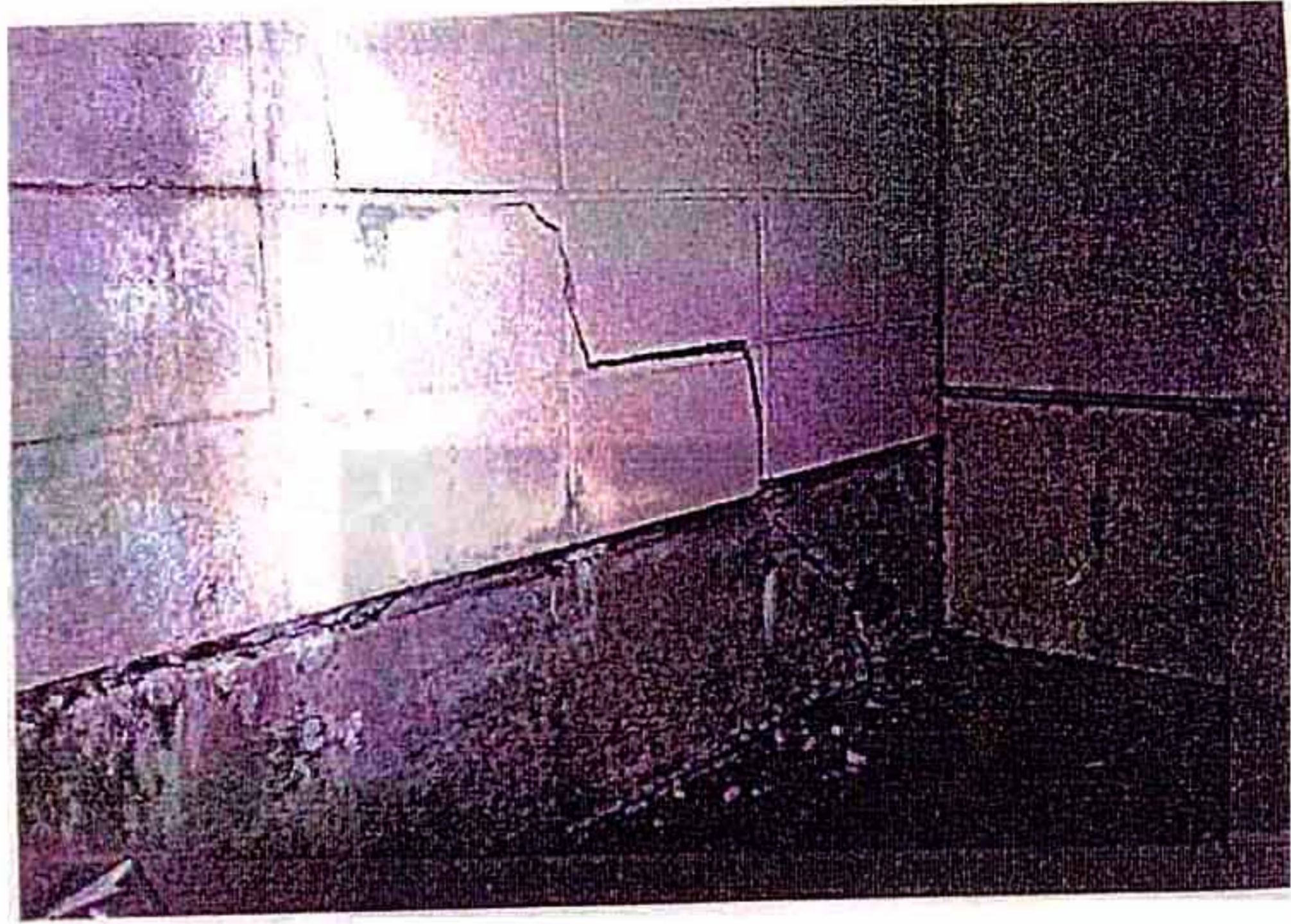
プールサイドのブロック基礎
