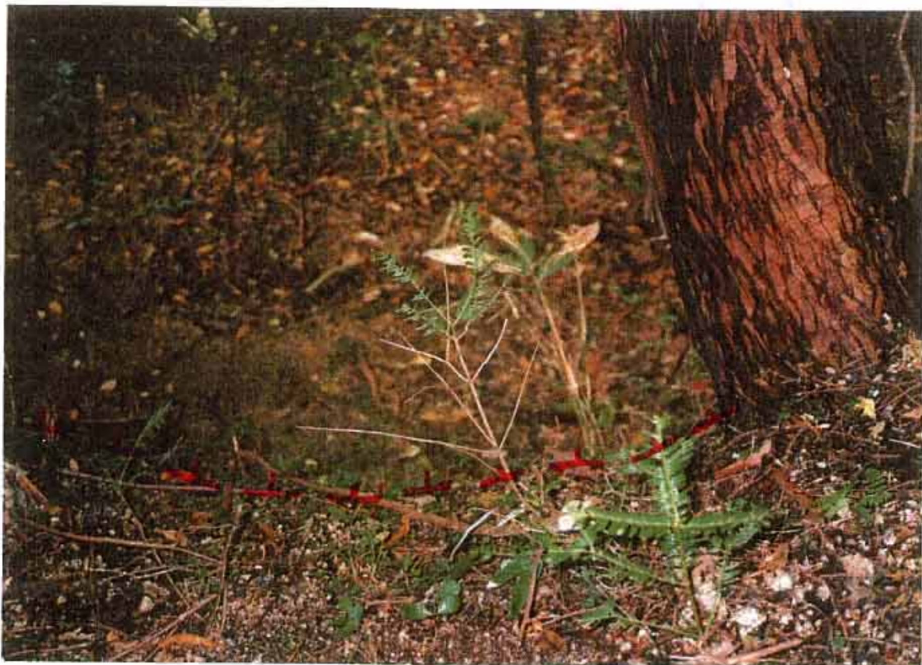
P-28 導水トンネル通過地点の地表に認められた崩壊地。幅 15m、長さ 7m、深さ 1~2mの規模であるが、発電施設に直接の影響はない。
