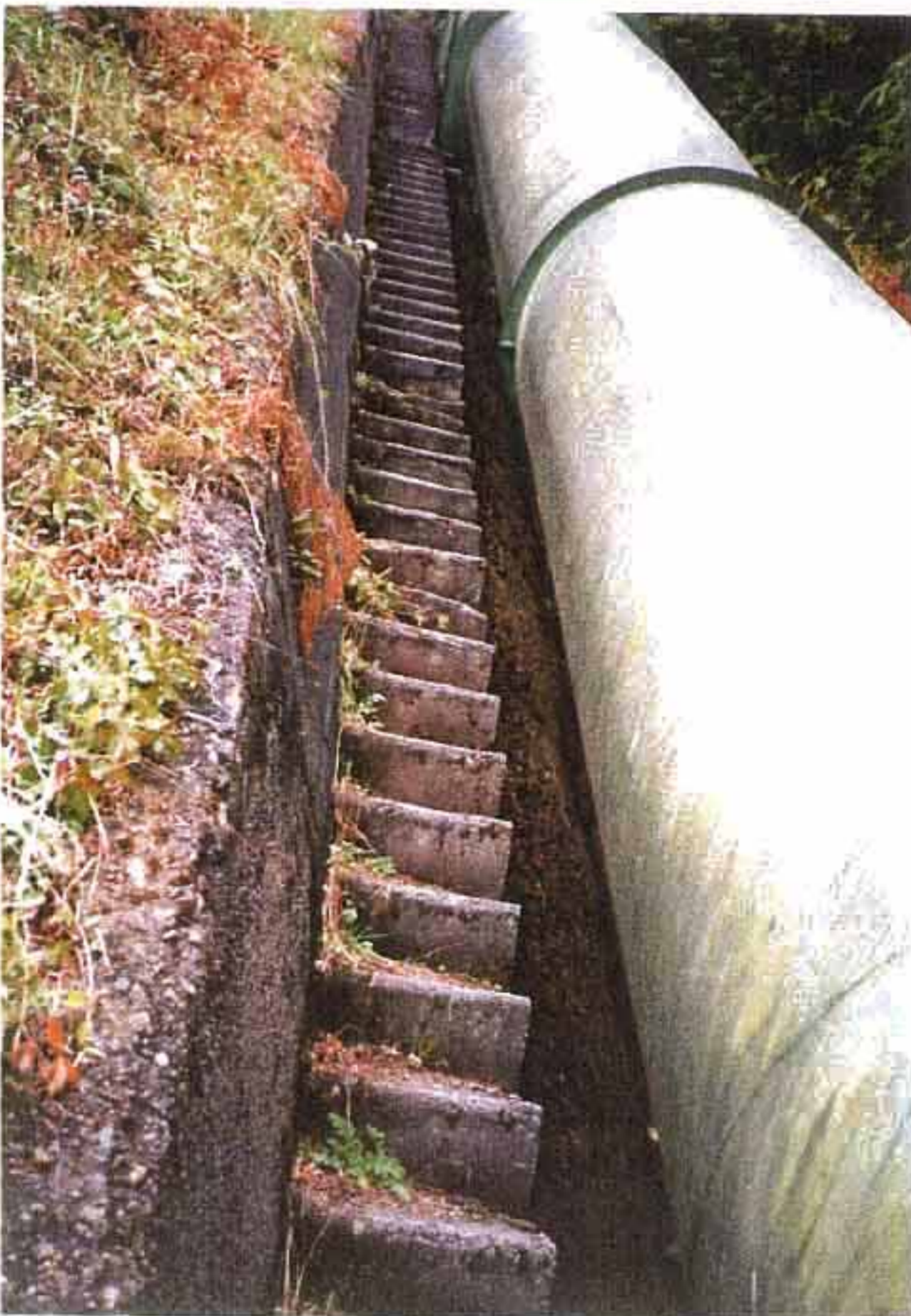
P-39 この区間の擁壁に顕著な変状は認め られない。
