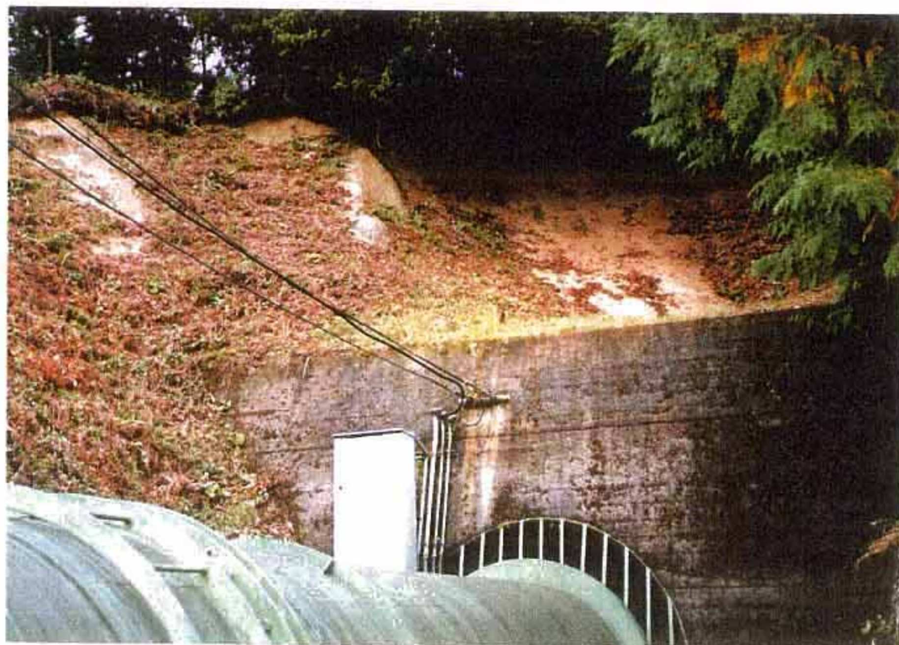
P-23 No.1 固定台と地山との間に生じた隙 間。最大幅約 10cm。
