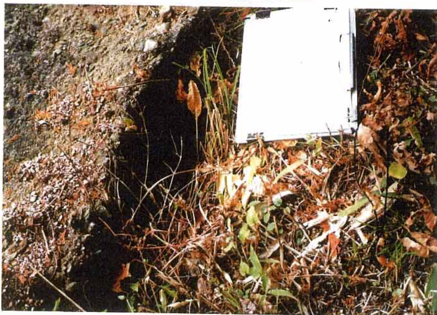
P-16 長さ約 15mにわたり、擁壁と地山との間に幅 20cm 程度の隙間が生じている。隙間の深さは最大 80cm。
