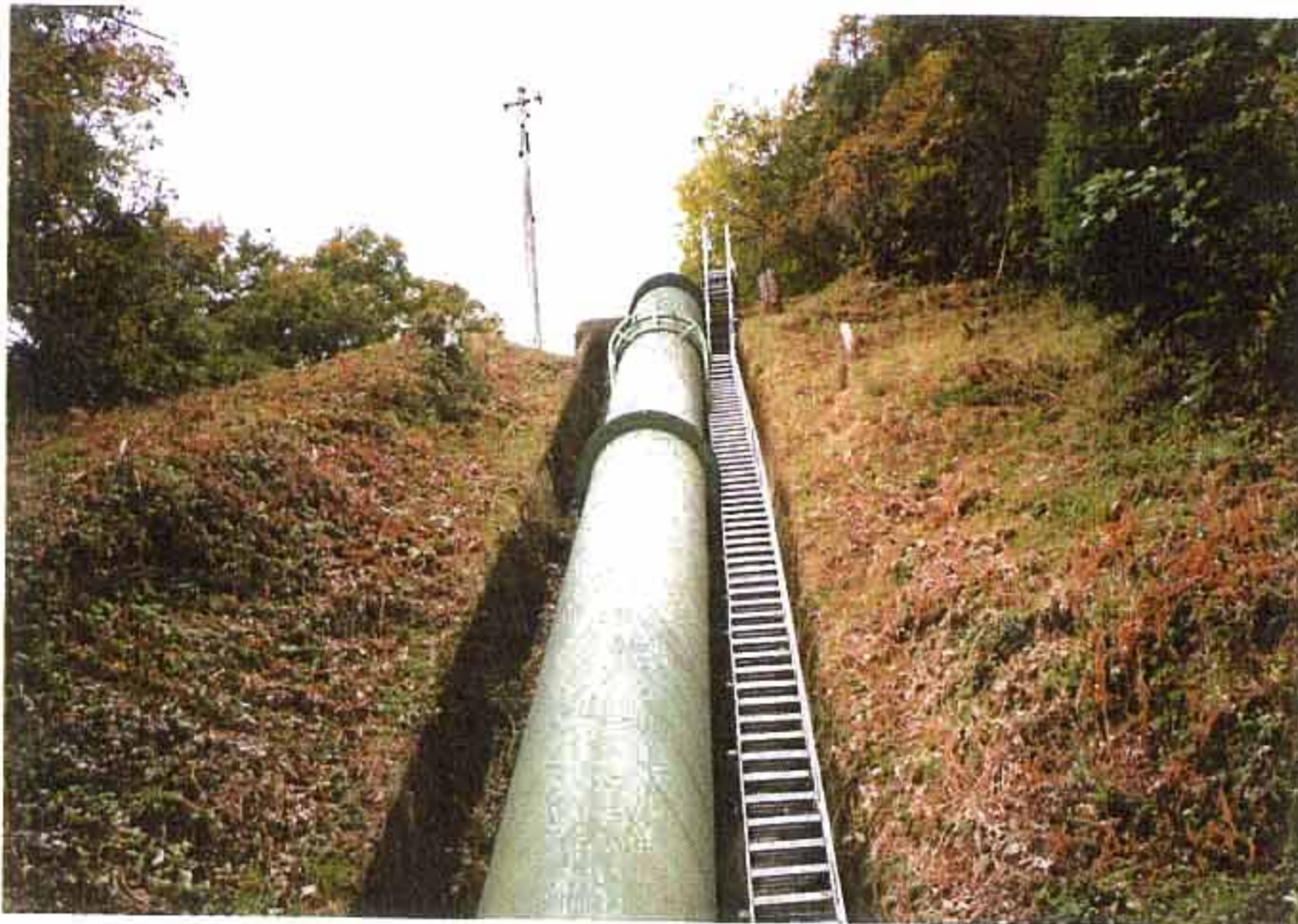
P-2 発電所より鉄管路を望む。
