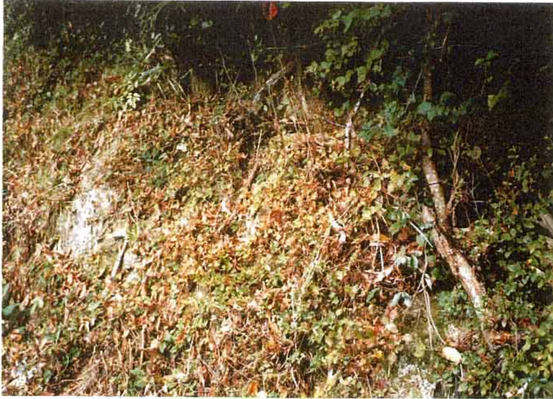
P-10 No.2 固定台付近の露岩状況。固定台基礎の少なくとも一部は CL 級以上の基盤花崗岩に着岩しているものと推定される。
