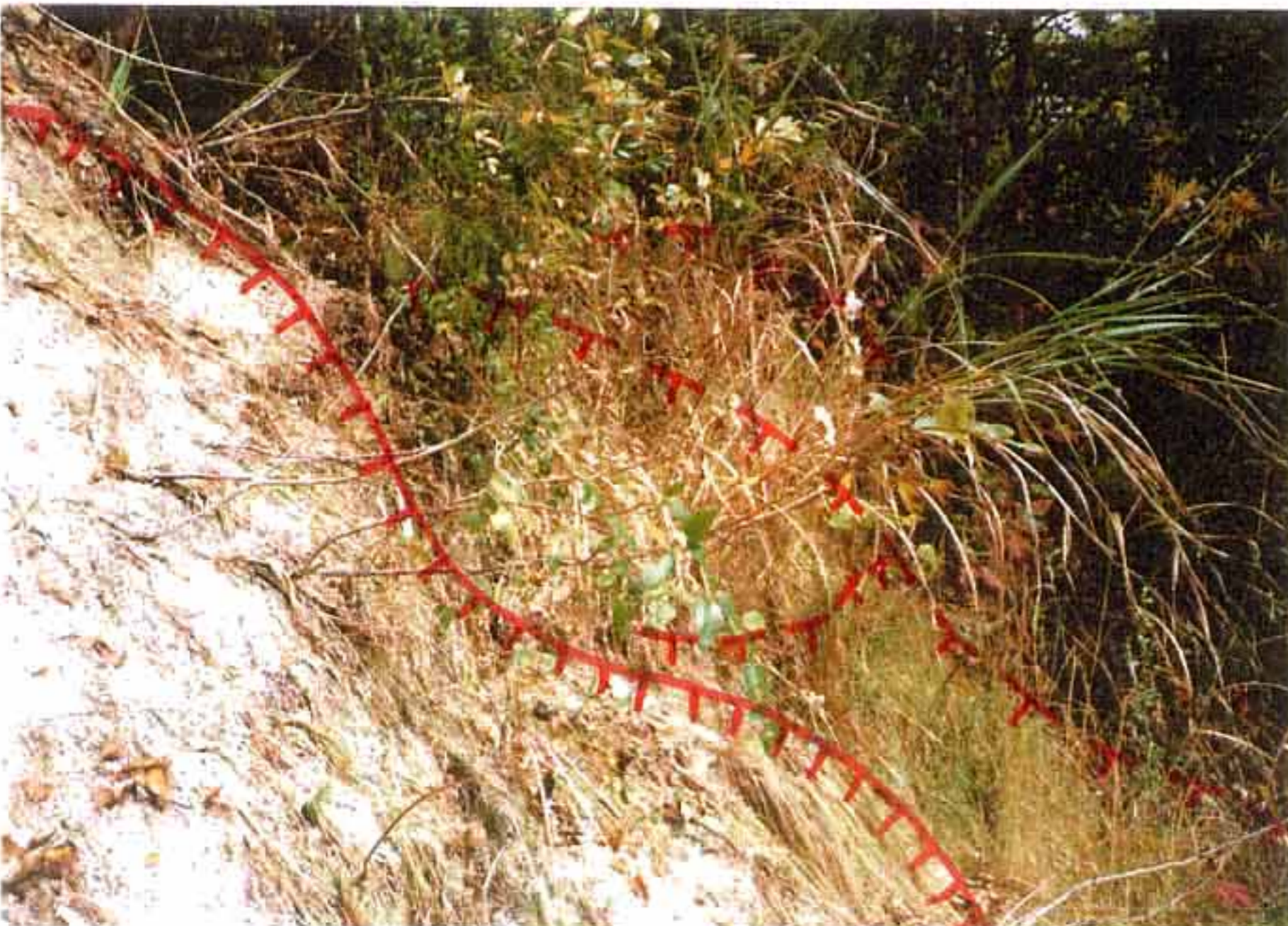
P-6 崩壊地の側方には古い滑落崖や段差地形が存在する。
