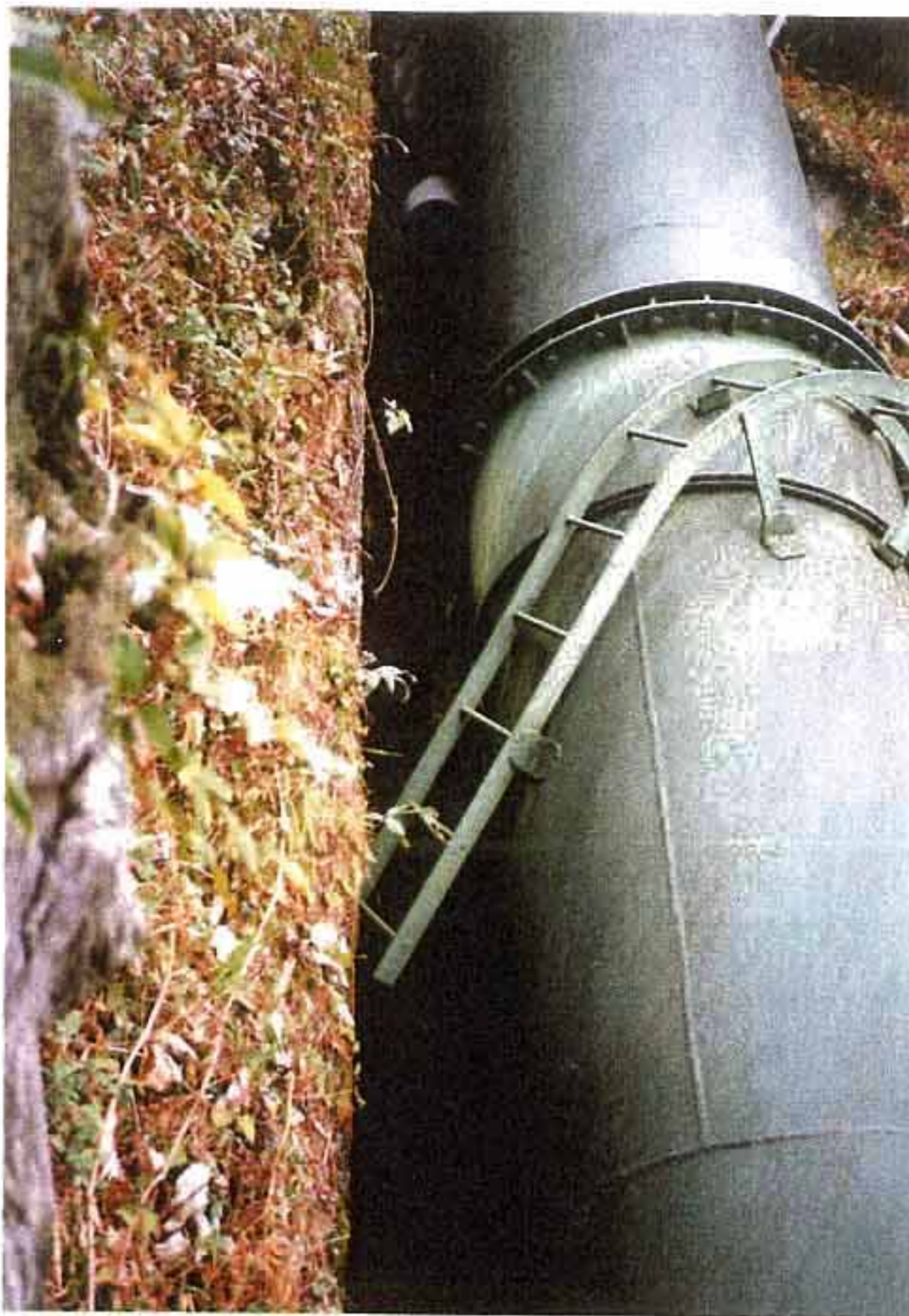
P-48 No.3 固定台直下の鉄管路の状況。 顕著な変状は認められない。
