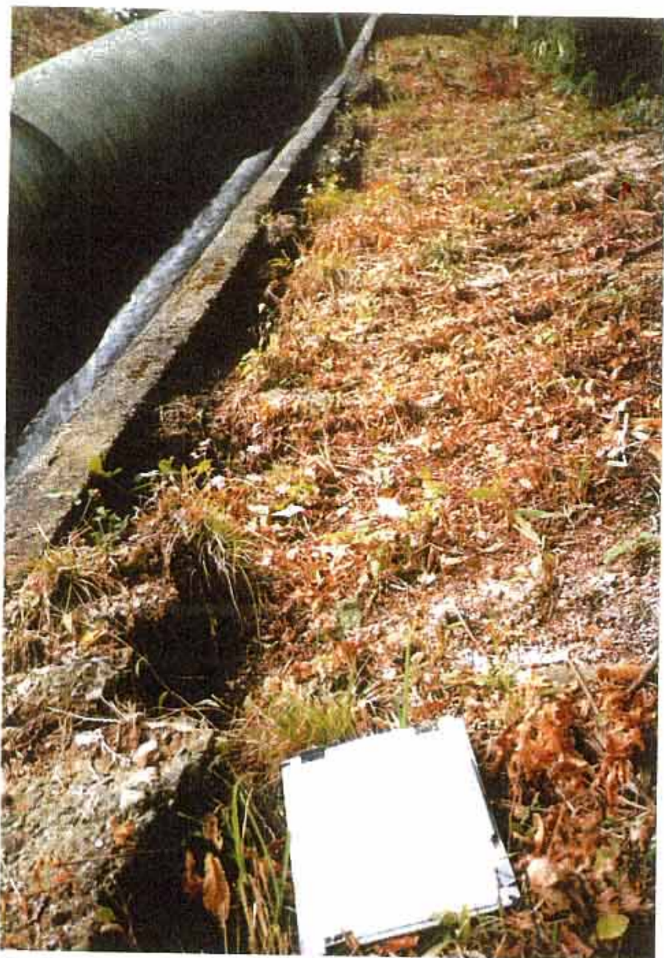
P-16 長さ約 15mにわたり、擁壁と地山との間に幅 20cm 程度の隙間が生じている。隙間の深さは最大 80cm。
