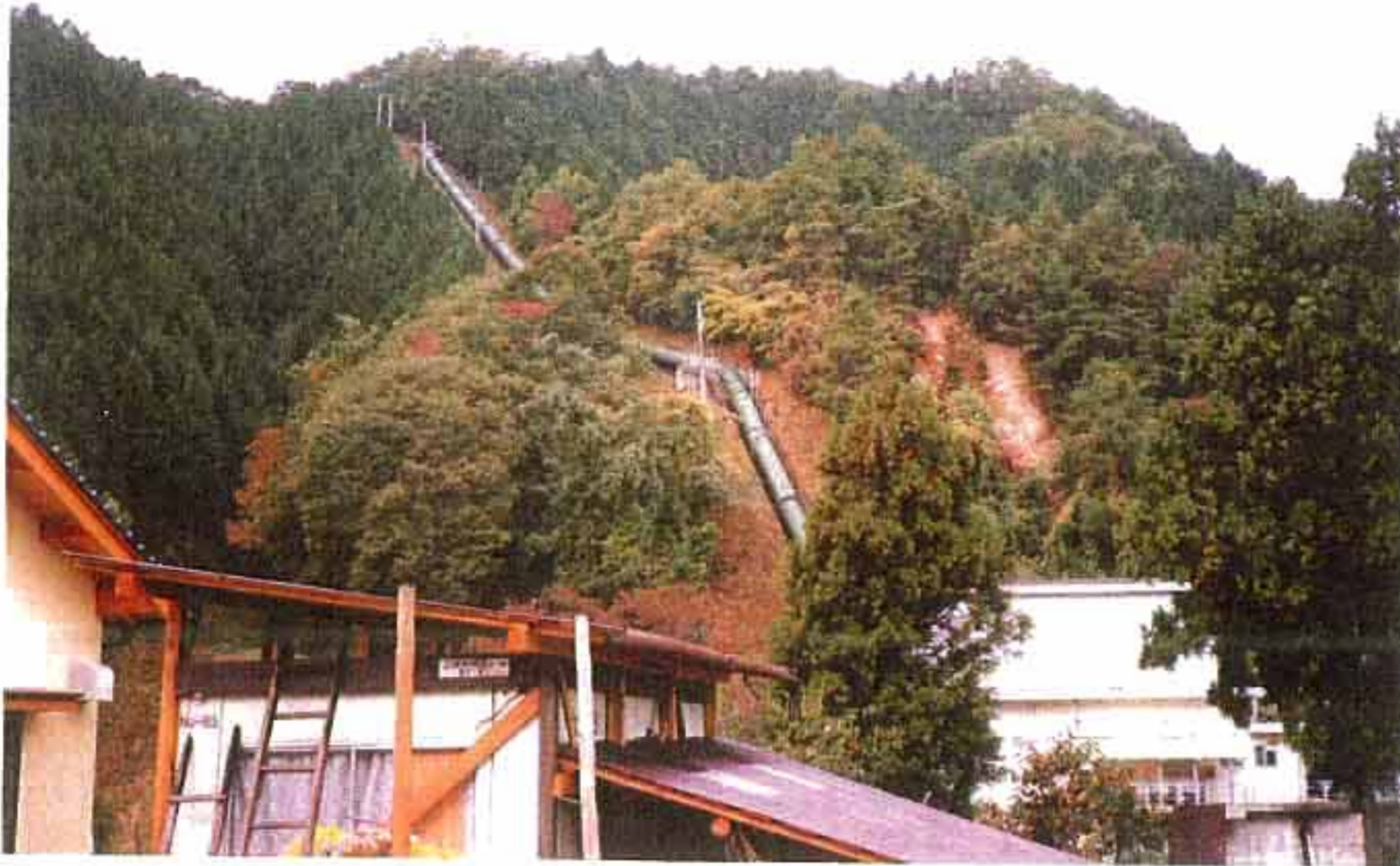
P-1 日野川第一発電所水圧管路遠景。
