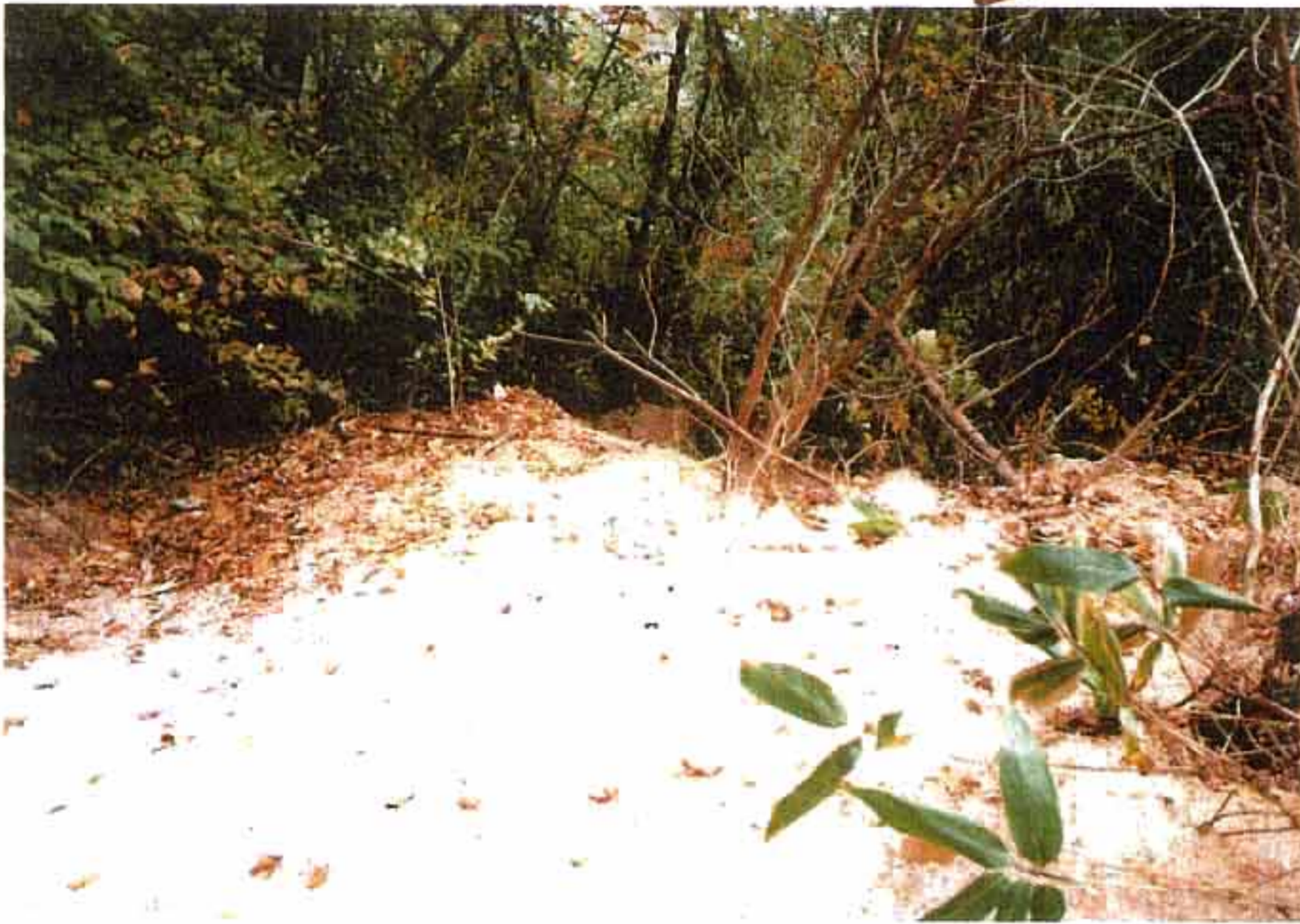
P-5 滑落崖より下方を望む。崩壊地下部にはルーズな崩積土が相当量堆積している。
