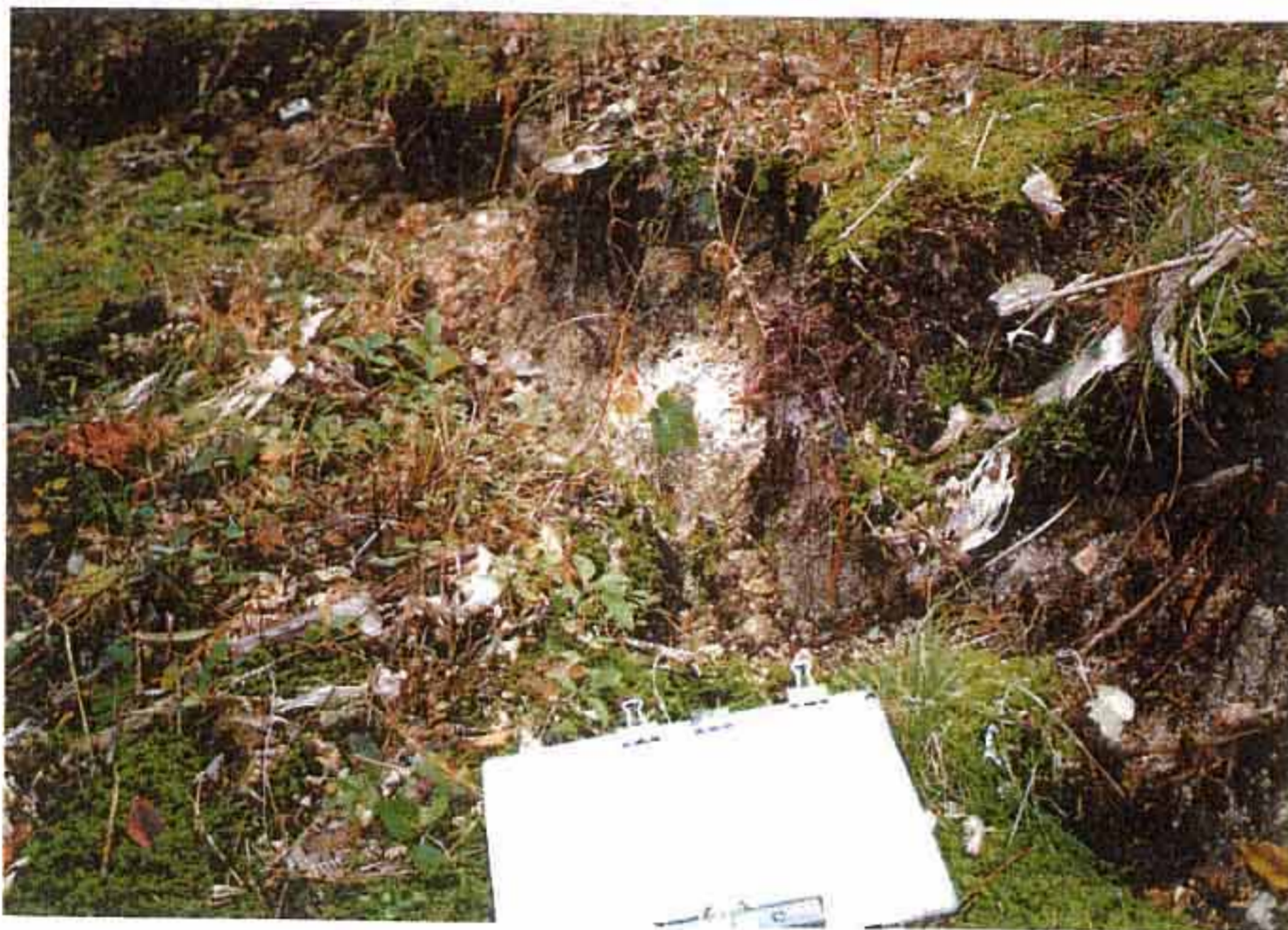
P-34 同じく 388m 盤（切盛境）に生じた 長さ 6~7m、最大開口幅 40cm、段 差 30cm 程度のクラック。
