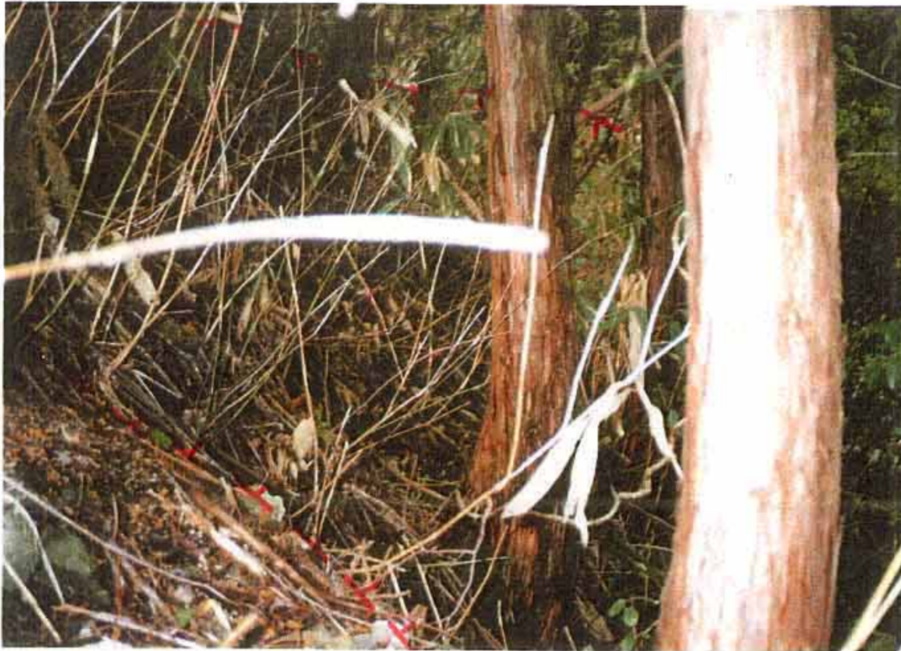
P-19 No.1 固定台東側谷筋の谷頭崩壊跡を側方より望む。 幅 15~20m、長さ 25m+、深さ 0.5~1m程度の規模を持つが、極めて旧く現状では植生が回復している。
