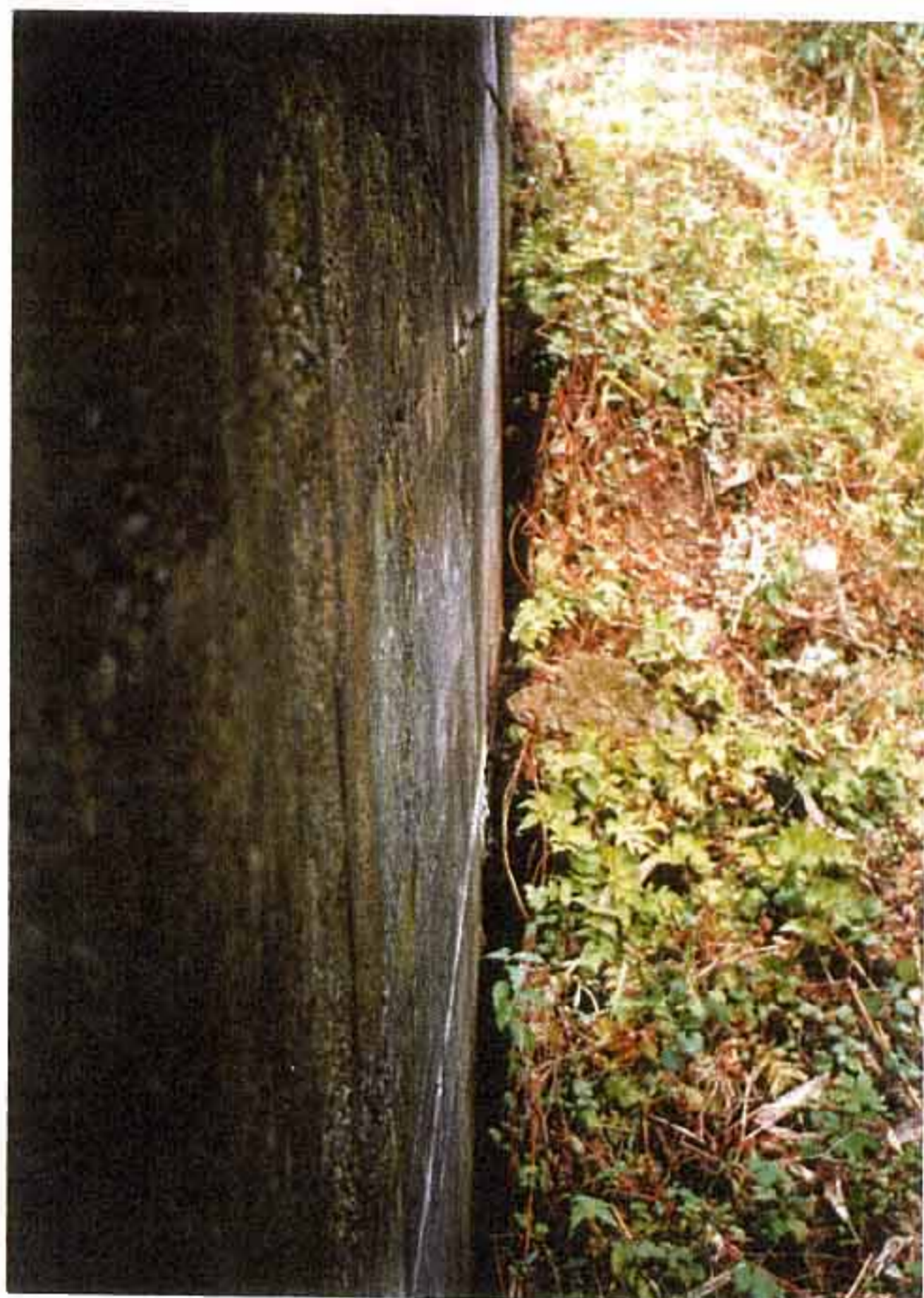
P-23 No.1 固定台と地山との間に生じた隙 間。最大幅約 10cm。
