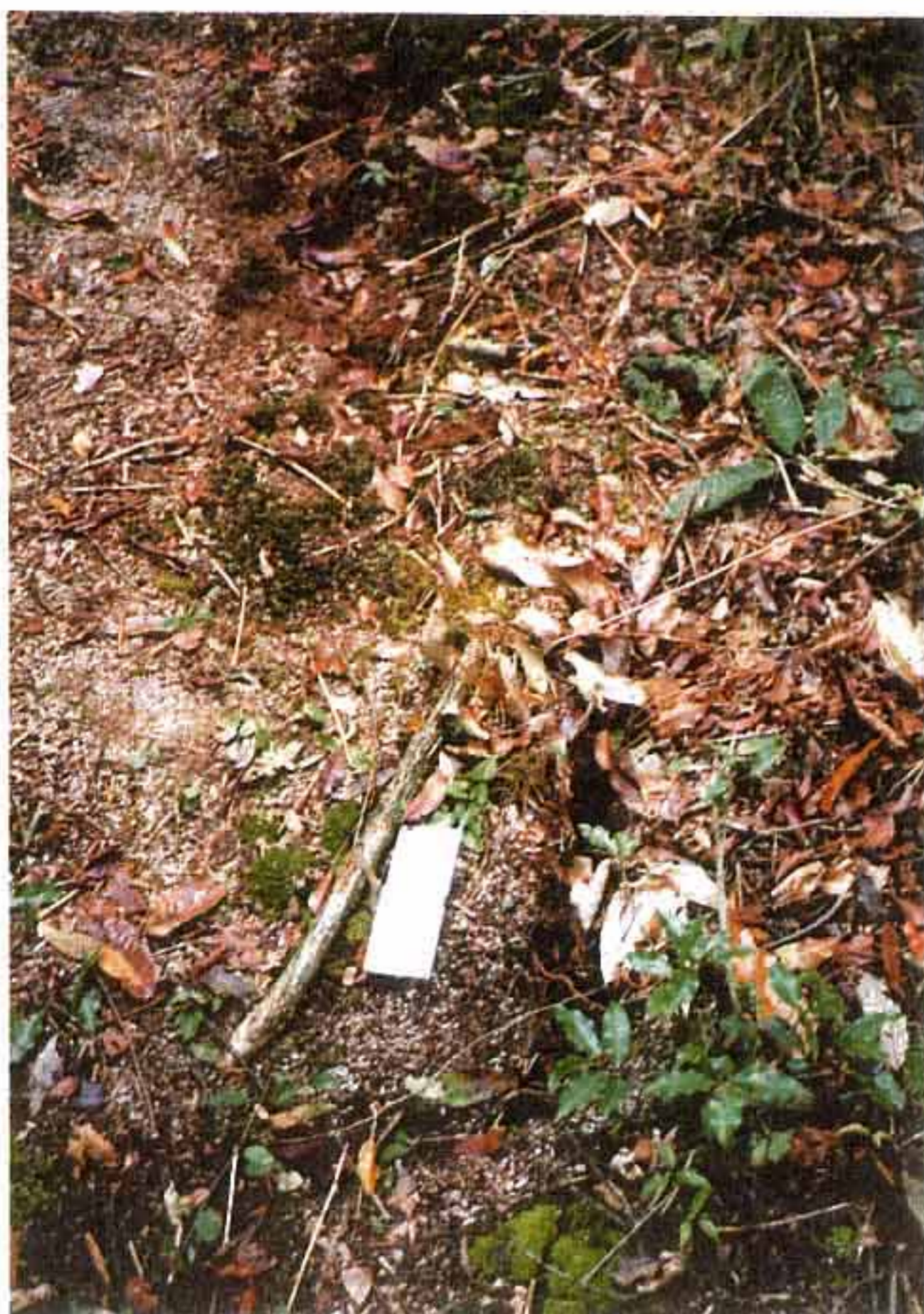
P-30 導水トンネル直上部の地表に見られたクラック。長さ 2.5m、開口幅 5cm 程度。
