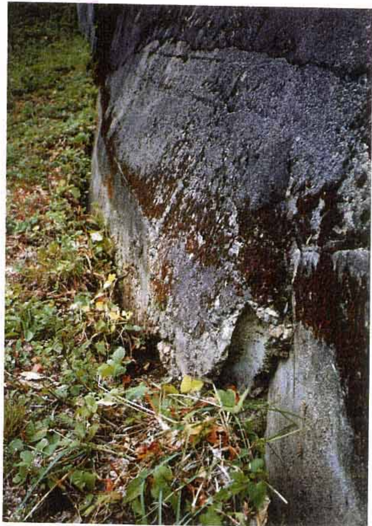
P-46 P-45 と同じ区間を斜面下方より望 む。
