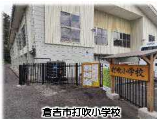
倉吉市打吹小学校
