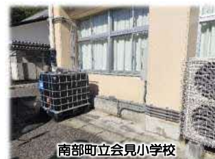
南部町立会見小学校
