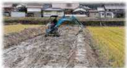
畦畔補強の施工状況
