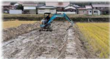
畦畔補強の施工状況
