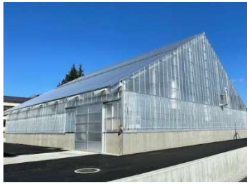
コンテナ苗生産施設（R3.12 日南町）
