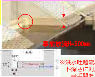
洪水吐越流堰スリット
