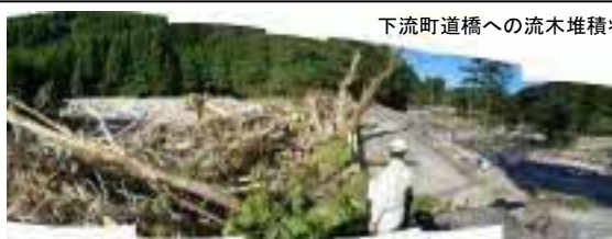
下流町道橋への流木堆積状況
