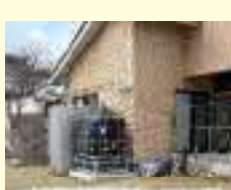
小規模多機能施設しじみの郷(湯梨浜町上浅津)
