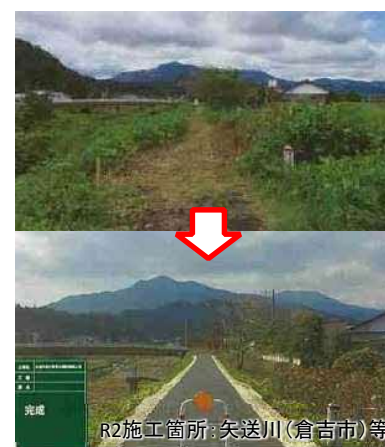
R2施工箇所: 矢送川(倉吉市)等 バックウォーター区間、重要水防区間A における堤防舗装を実施
