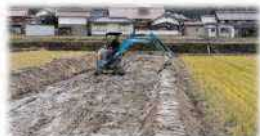
畦畔補強の施工状況
