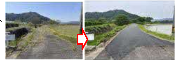
R7施工箇所：八東川（八頭町）
