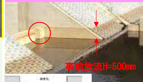
洪水吐越流堰スリット
