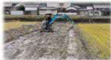
畦畔補強の施工状況
