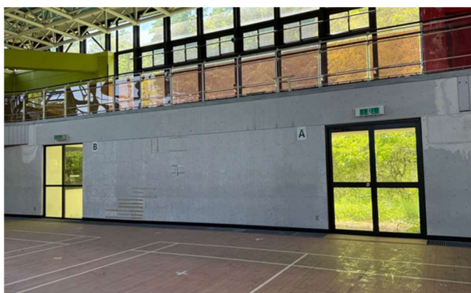
②トレーニングホール非常口
