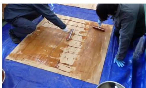
写真1 接着剤の塗布状況
