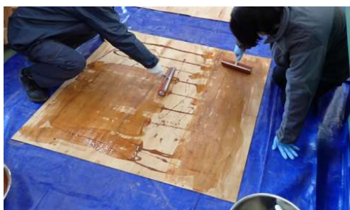
写真1 接着剤の塗布状況
