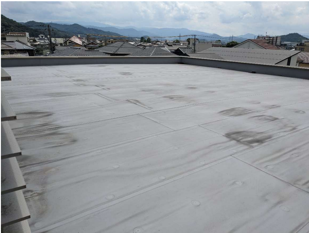
● 庁舎棟 2階屋上（室外機置場より東南方向を望む）
