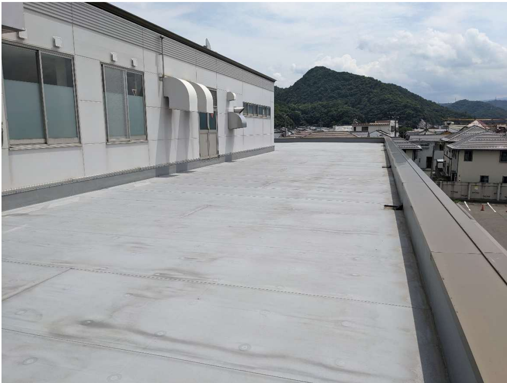
● 庁舎棟 2階屋上（西端より東方向を望む）
