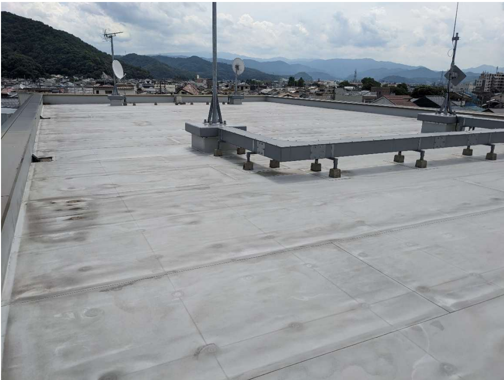
● 庁舎棟 3階屋上（西端より東方向を望む）
