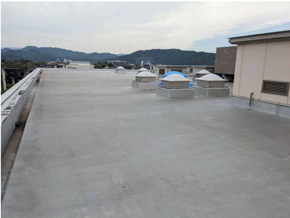
●管理試験棟屋上（北端より南方向を望む） ※R8 年度防水改修工事中：防水改修前状況
