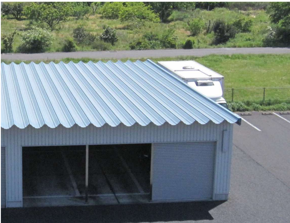
●車庫棟折版葺屋根（GL カラー鋼板）
