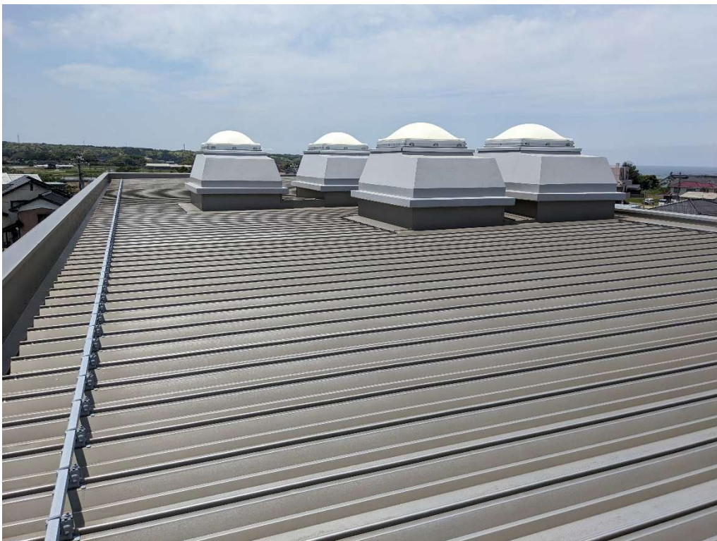
●車庫棟屋上東側（東端より西方向を望む）
