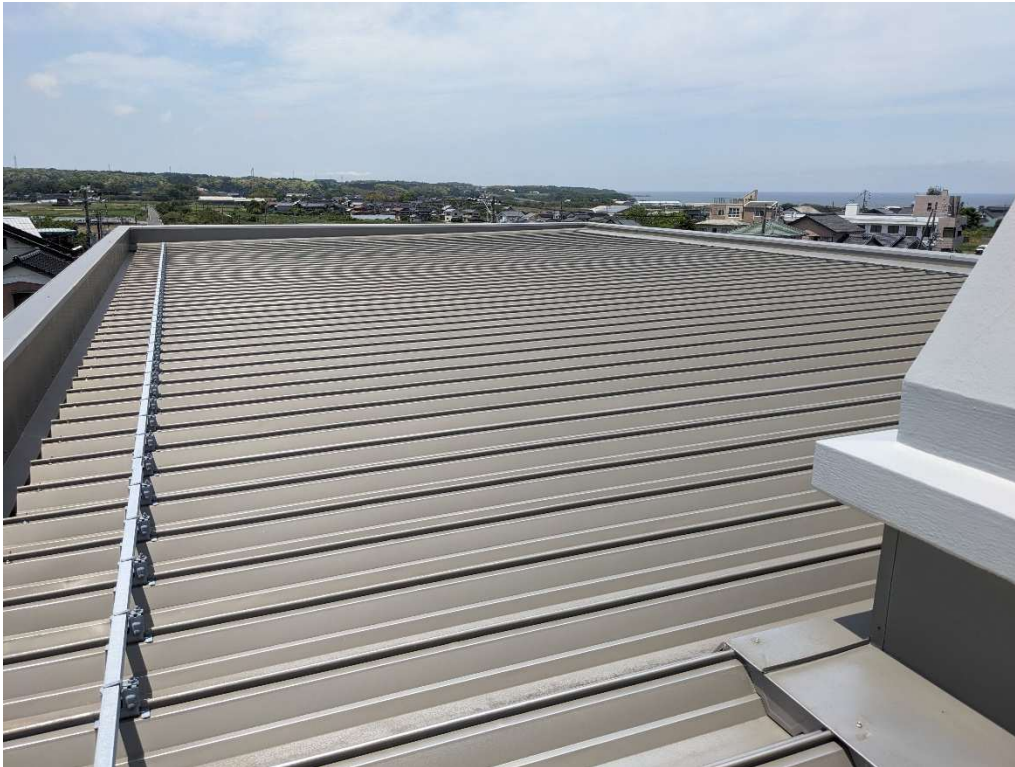
●車庫棟屋上西側（中央より西方向を望む）
