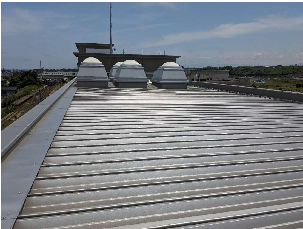
●車庫棟屋上西側（西端より東方向を望む）
