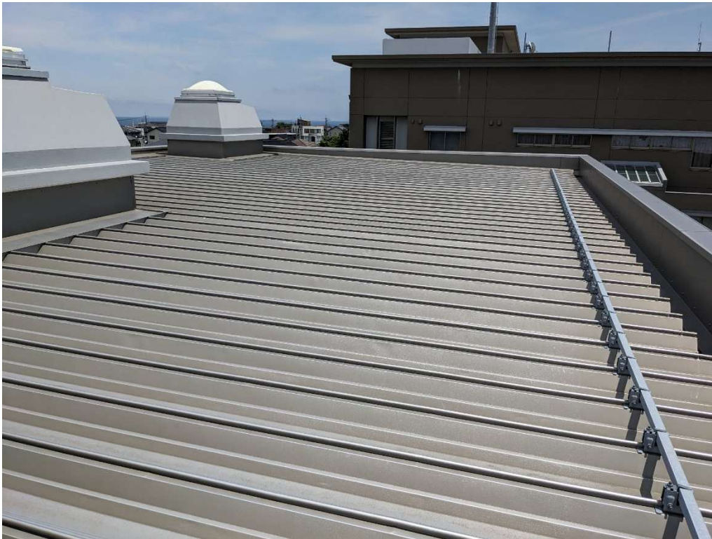
●車庫棟屋上東側（中央より東方向を望む）
