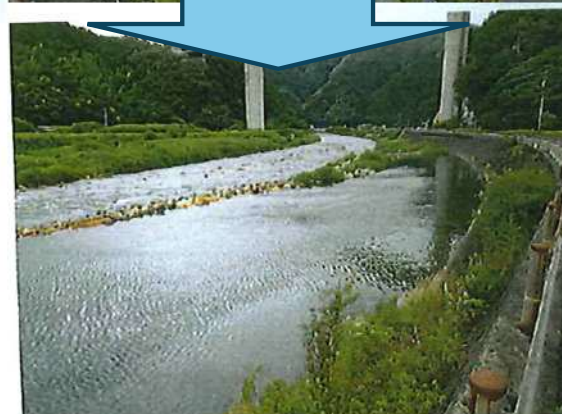
完了後（導水確保）
