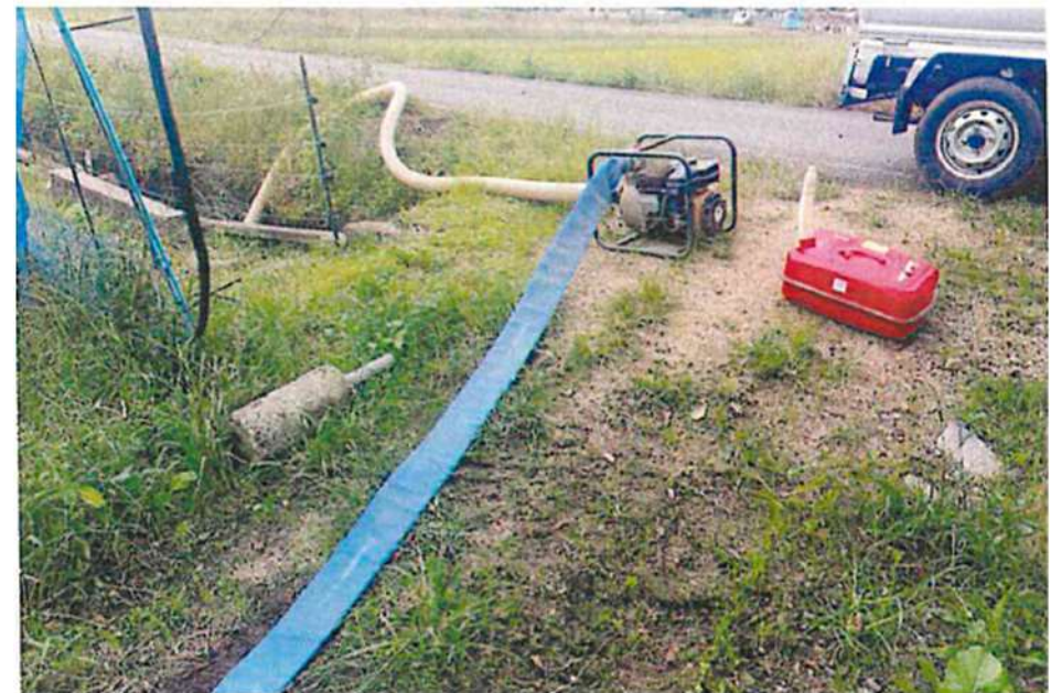
ポンプによる取水状況
