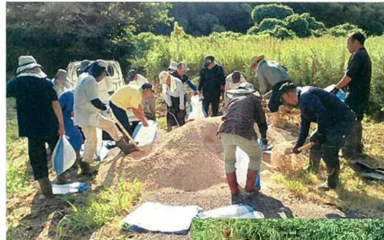
土のう拵え作業
