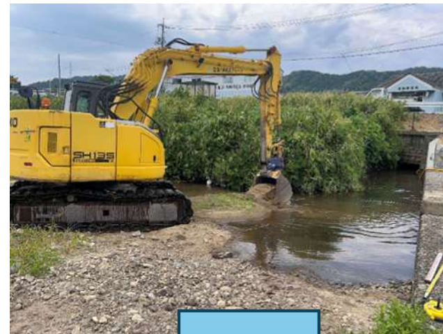
河川掘削作業
