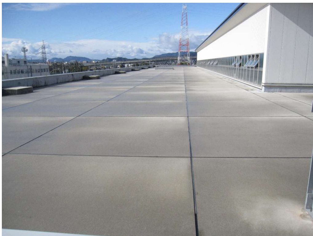
● 2号上屋 屋上南側（西側を望む）
