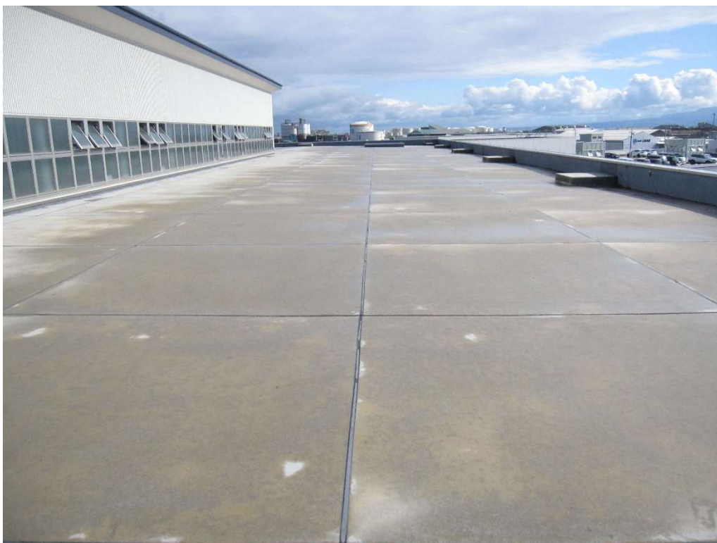
● 2号上屋 屋上南側（東方向を望む）
