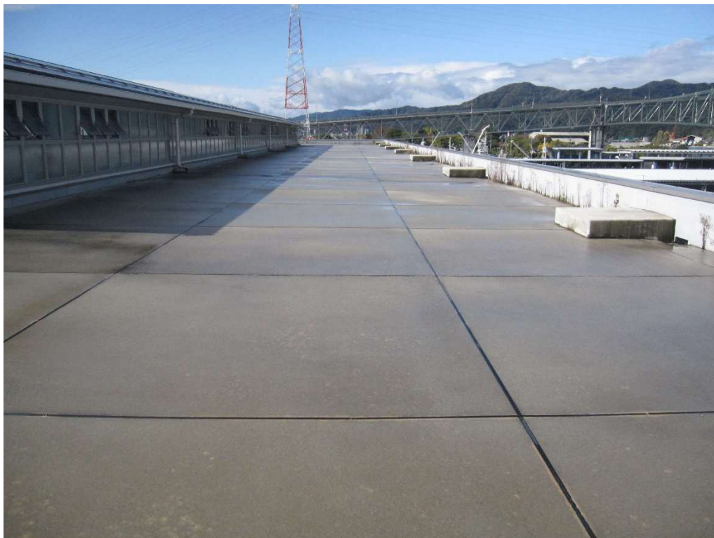
● 2号上屋 屋上北側（西方向を望む）
