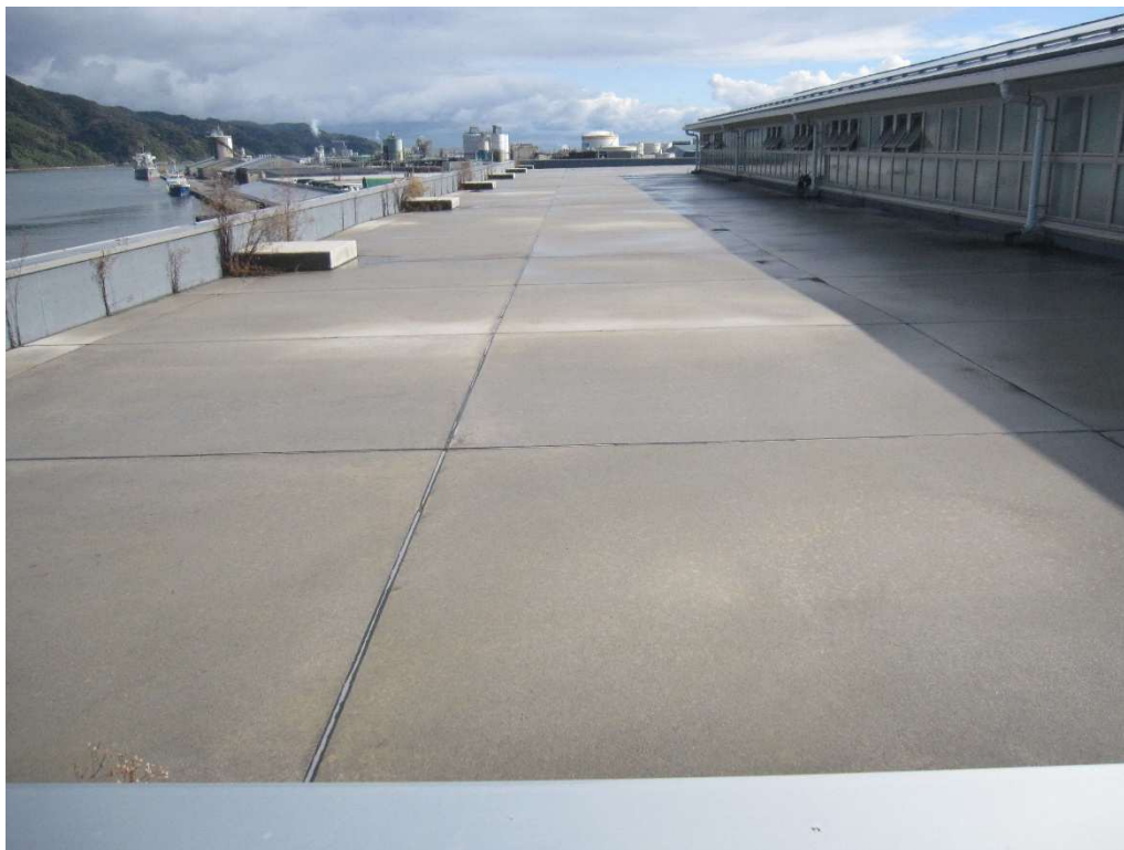
● 2号上屋 屋上北側（東方向を望む）
