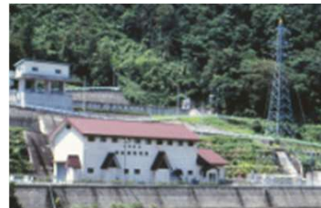
【新幡郷発電所】
