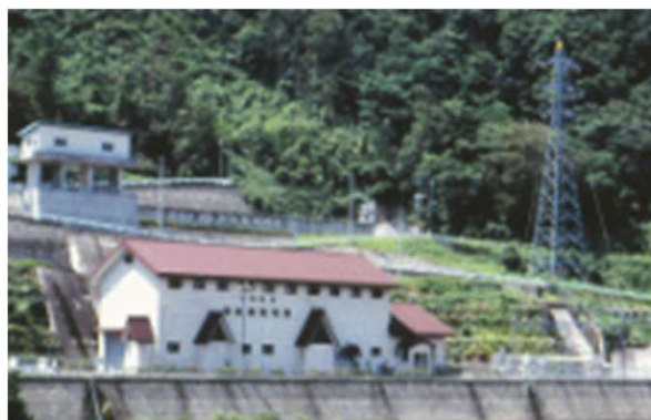
【新幡郷発電所】
