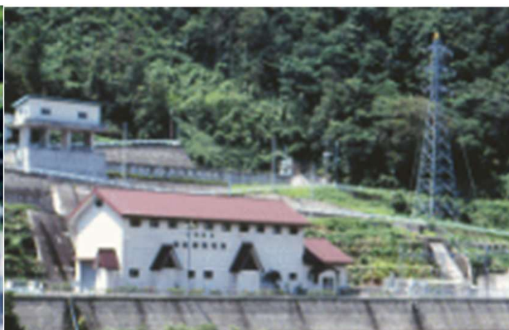
新幡郷発電所
