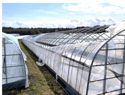
パイプハウスのビニール破れ被害（北栄町）
