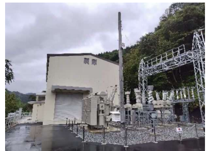
日野川第一発電所（外観）
