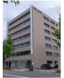
オフィス入居ビル (米子第一生命ビル)
